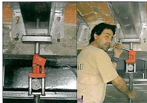
Montaje mediante gato hidráulico.
